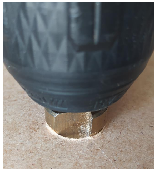
Abbildung 10 Bohren der Rückwand für die Kabeldurchführung
