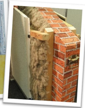
Abbildung 3 Wärmedämmung an der Wand 5
